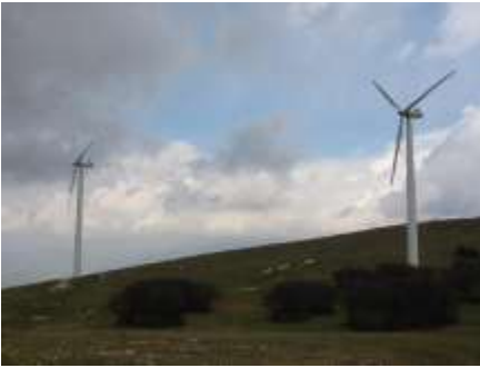
Foto : parco eolico
